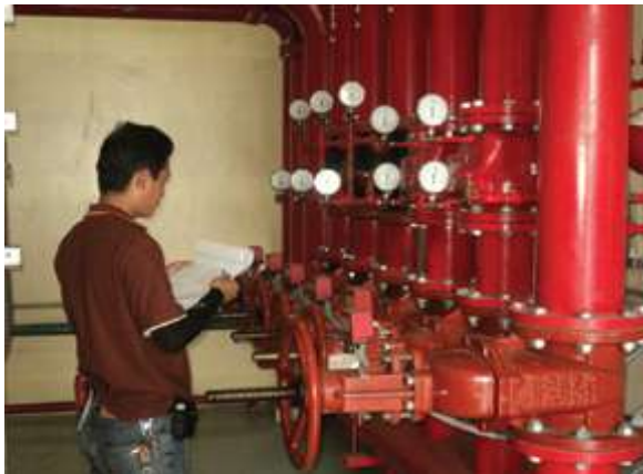
ภาพที่ ๓๘ การตรวจสอบระบบดับเพลิงด้วยน้ำ
