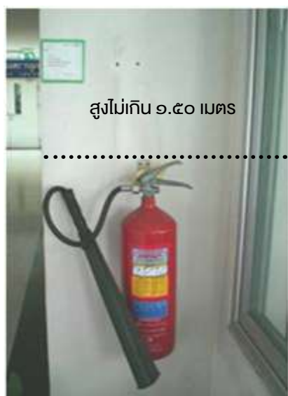
ภาพที่ ๑๗ ความสูงของการติดตั้งเครื่องดับเพลิงแบบมือถือ
